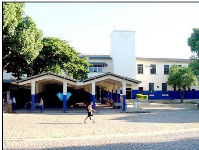
Figura 3.20 – Estação Ferroviária de Gov. Valadares.
