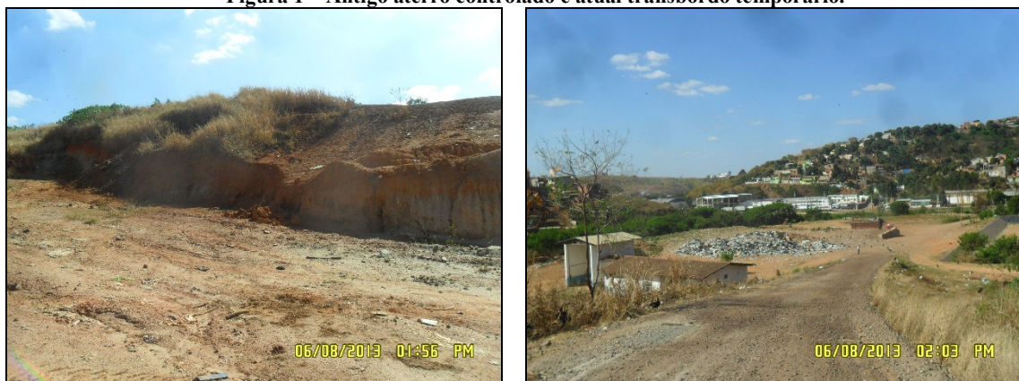
Figura 1 – Antigo aterro controlado e atual transbordo temporário.
